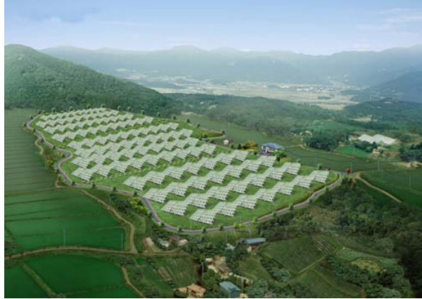
그림 6. 전남 강진에 계획 중인 1.2MW급 태양광 발전소
