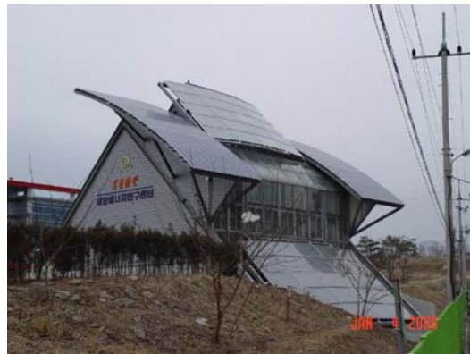
그림 5. 고정형 태양광 발전의 설치 예
