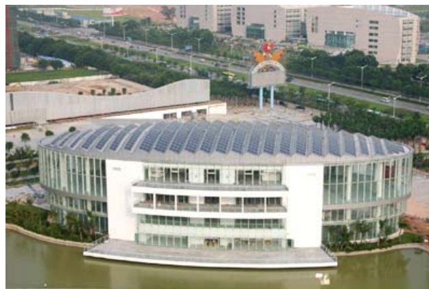
그림 6. BIPV 설치의 예
